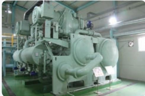
터보 히트펌프는 적은 양의 에너지로 열 역학적 사이클을 구동해 낮은 온도의 열에너지를 높은 온도의 열에너지로 'Pumping' 하는 장치입니다. (최고 80°C 온수 생산 가능)
